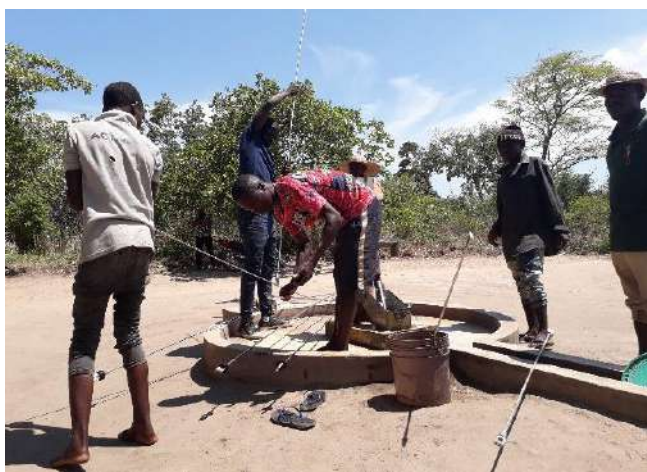
Réparation d'un ouvrage par un comité villageois (district de Mogincual)
