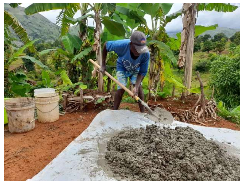
Fabrication d'une dalle de latrine par un entrepreneur
