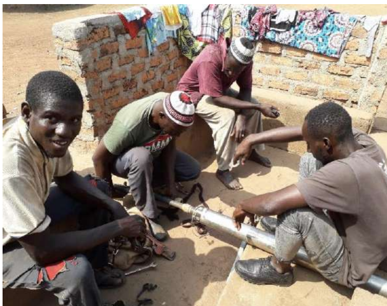
Réparation par l'artisan de Koumban (pompe Vergnet)
