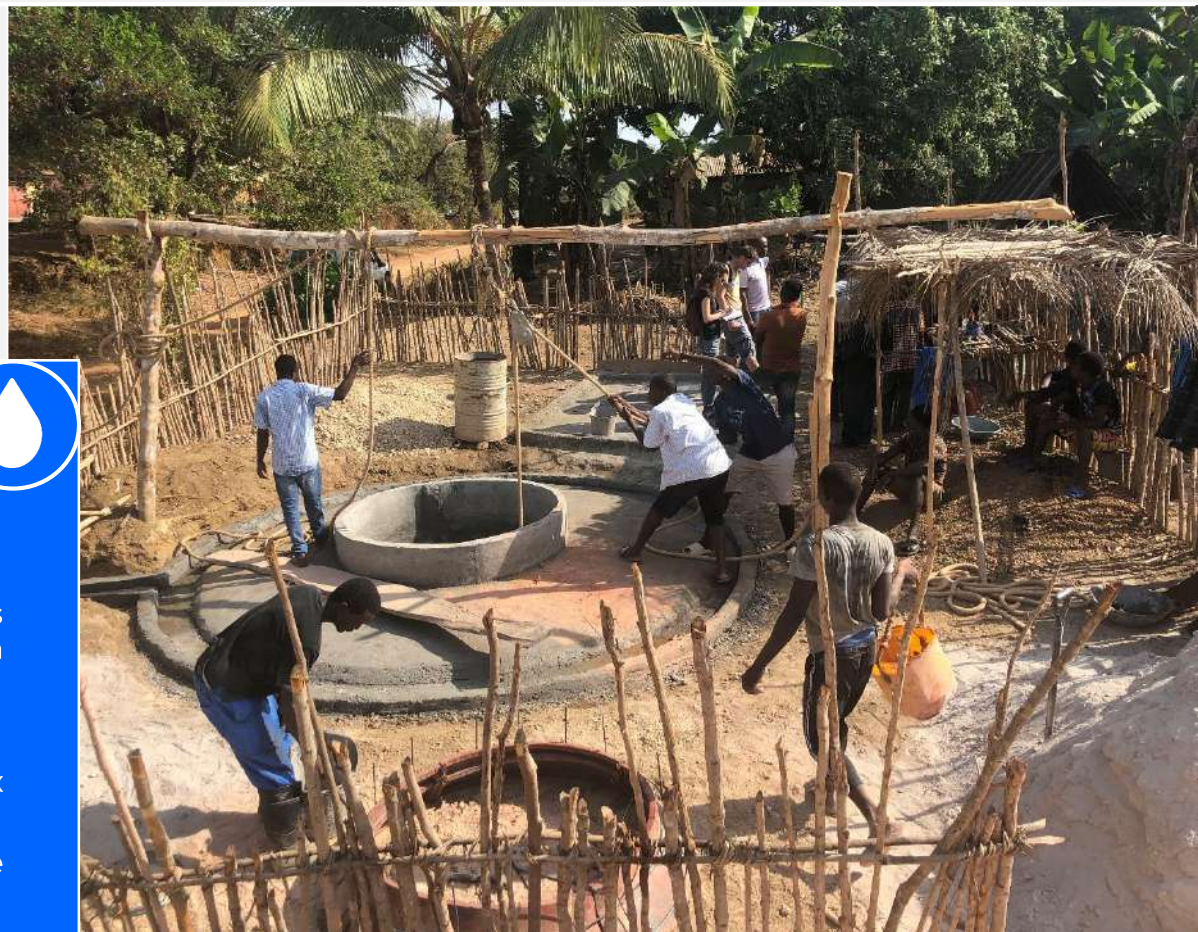
Co-construction d'un puits protégé, Sierra Leone
