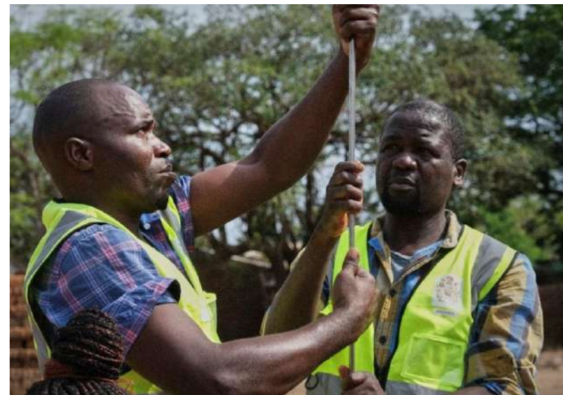
Réparation d'une pompe défectueuse par deux artisans-réparateurs dans le district de Balaka (région Centre)
