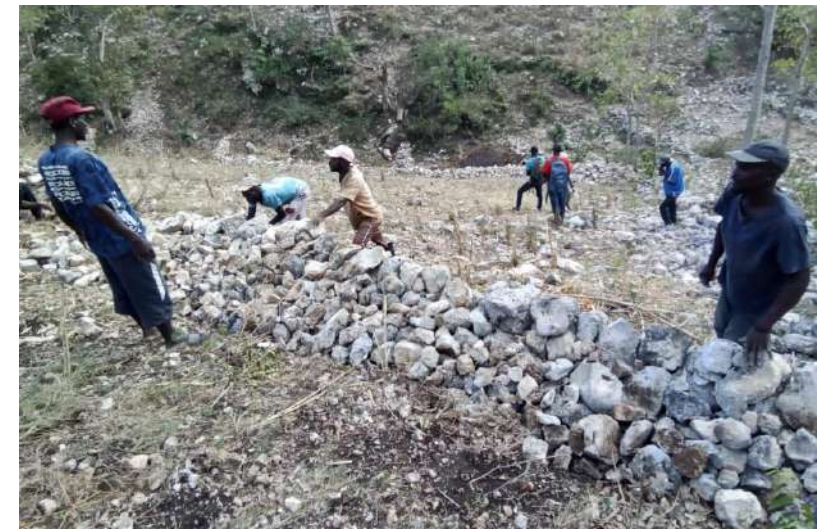
Mise en place de murs de pierres sèches pour réduire l'érosion des parcelles et transformer ces terres incultes en jardin productif
