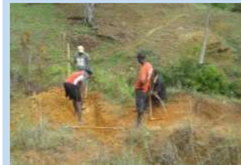
Premier travaux de fouilles sur la source de Kalmader
