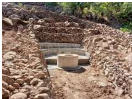
Captage de la source de Bulbe dans la commune de Zulo Gamo - District de Kucha
