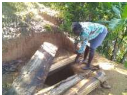
Vérification de la profondeur de la latrine
