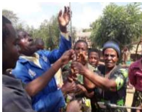
Maintenance d'un point d'eau par un réparateur privé partenaire (Mchinji)
