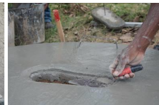
La main experte du maçon
