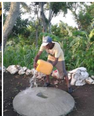
L'arrosage régulier pendant le séchage est déterminant pour la solidité de la dalle
