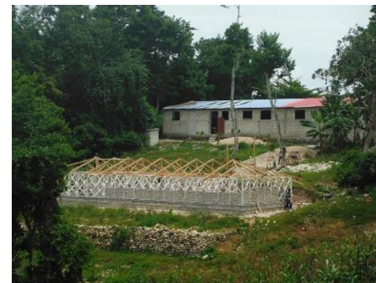
Chantier de l'école communautaire de Lexis
