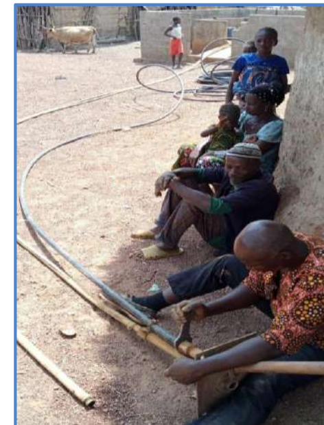
Démontage et réhabilitation d'une pompe par l'artisan-réparateur de la zone en Guinée
