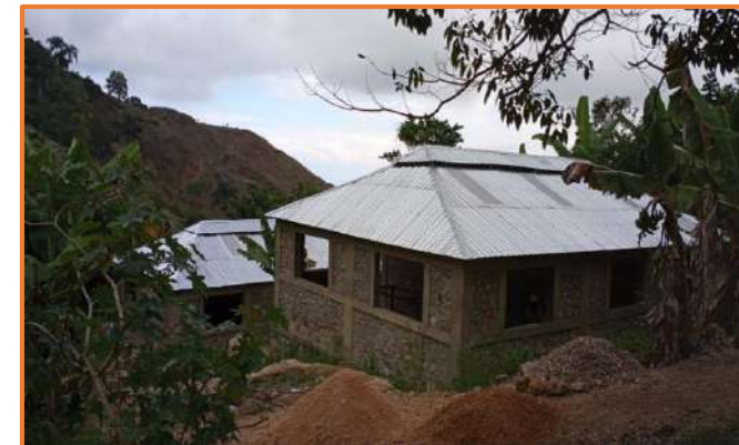
Chantier de construction pour l'école de Dlo Madam, à Grand-Goâve
