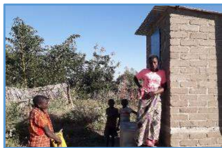
Latrine familiale hors-sol à Phalombe
