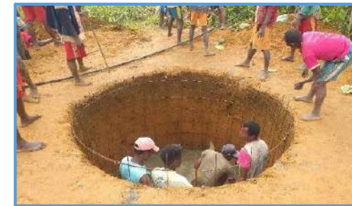
Zone de captage (à gauche) et construction de la citerne (à droite) du réseau d'adduction d'eau potable de la commune d'Ambalahady, de la région d'Analanjirifofo
