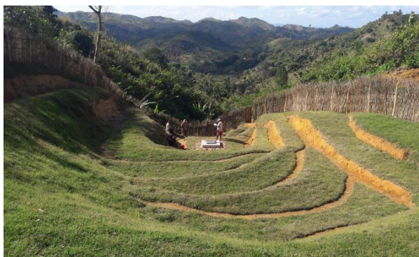
Captage de source Antsiradava Commune rurale Mahambo
