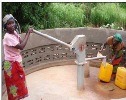
Forage mécanique équipé d'une pompe manuelle. District de Momba.
