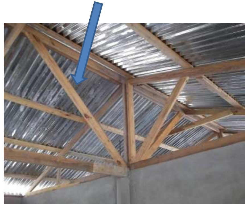
Contreventement de la charpente
