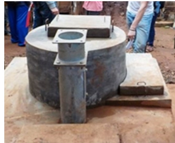
Vue arrière (ci-dessus) et avant (ci-dessous) du dispositif avant installation de la pompe
