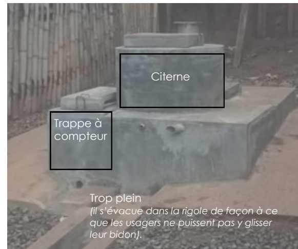
Vue arrière (ci-dessus) et avant (ci-dessous) du dispositif avant installation de la pompe
