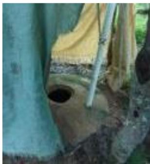
Photo : dalle réalisée par le maçon Levictoire pour un lakou qui s'est installé début 2012 dans la zone, après la période d'intervention d'Inter Aide. Le tuyau a été récupéré de la latrine du voisin dont la dalle est cassée.
